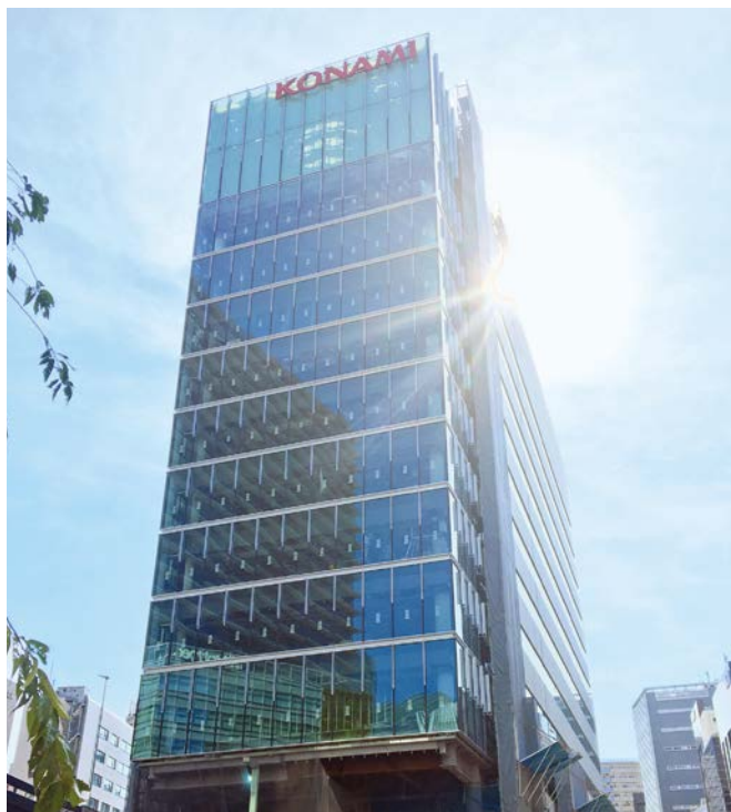
建設中の「コナミクリエイティブセンター銀座 (KCC銀座)」
